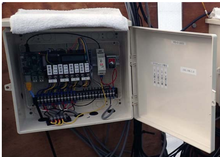
写真1 低コスト汎用基板のRaspberry Piを使った低コストUECS環境制御システムの中小規模施設への設置例
